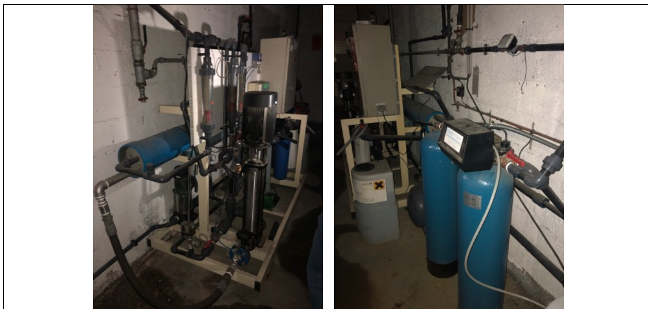
Production d'eau osmosée à déplacer
